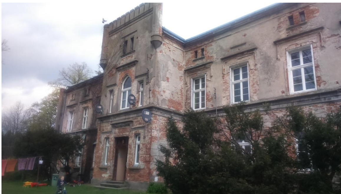
Rysunek 7 Budynek mieszkalny w Pomianach (dawny pałac) widok frontowy (źródło: Remedis SA)
