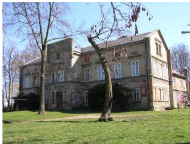
Zespół pałacowy w Pomianach został wybudowany ok. 1890 roku. Mury, piętrowy, neogotycki angielski, 3 ryzality, w narożnikach wieżyczki, wewnątrz hol z obszerną klatką schodową i sienią.
